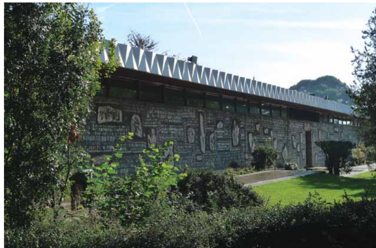
métallique est un bandeau de rive continu, en bardage métallique masquant les chêneaux, sur le débord de la toiture-parapluie qui protège le bâtiment et abrite le cheminement.
